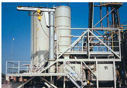
Gru a colonna con rotazione pneumatica, da 2,5 t.
